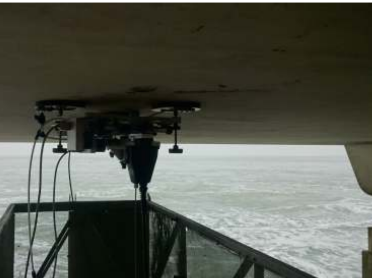
FiberLIBS bei der Vor-Ort Chloridbestimmung im Beton eines Nordsee-Sperrwerkes
